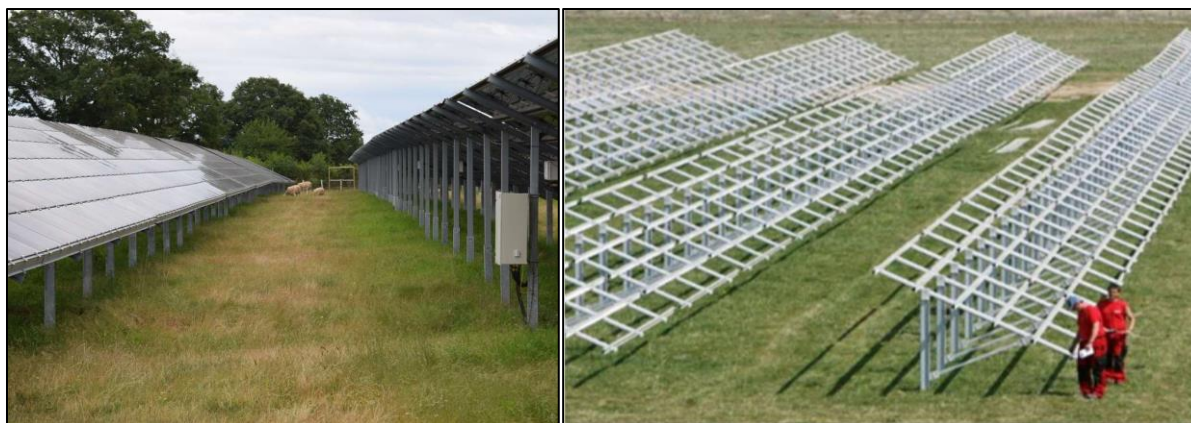
Photo 1 : Exemple de structures fixes orientés sud.
