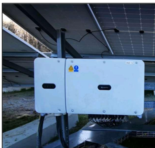
Photo 2 : Exemple d'onduleur décentralisé (source : Silversun).
