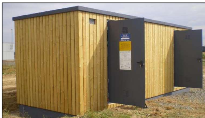
Figure 4 : Exemple de poste de livraison (source : Internet).
