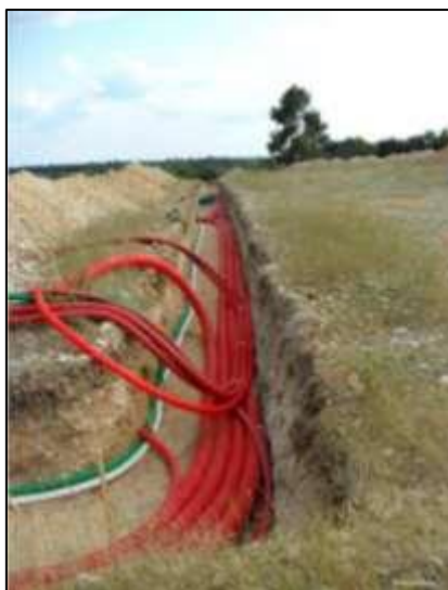
Photo 3 : Exemple de câblage au sol par tranchée (source : Internet).
