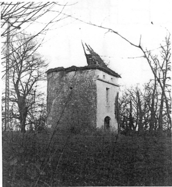
façade ouest ②
