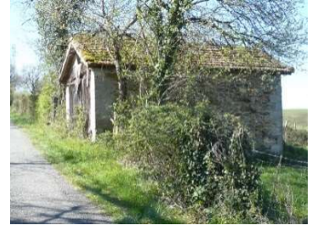
Bâtiment existant sur ZD 28
