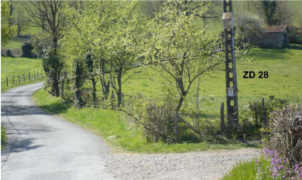
Parcelle ZD 28, le long de la route de Plancat - Poteau électrique
