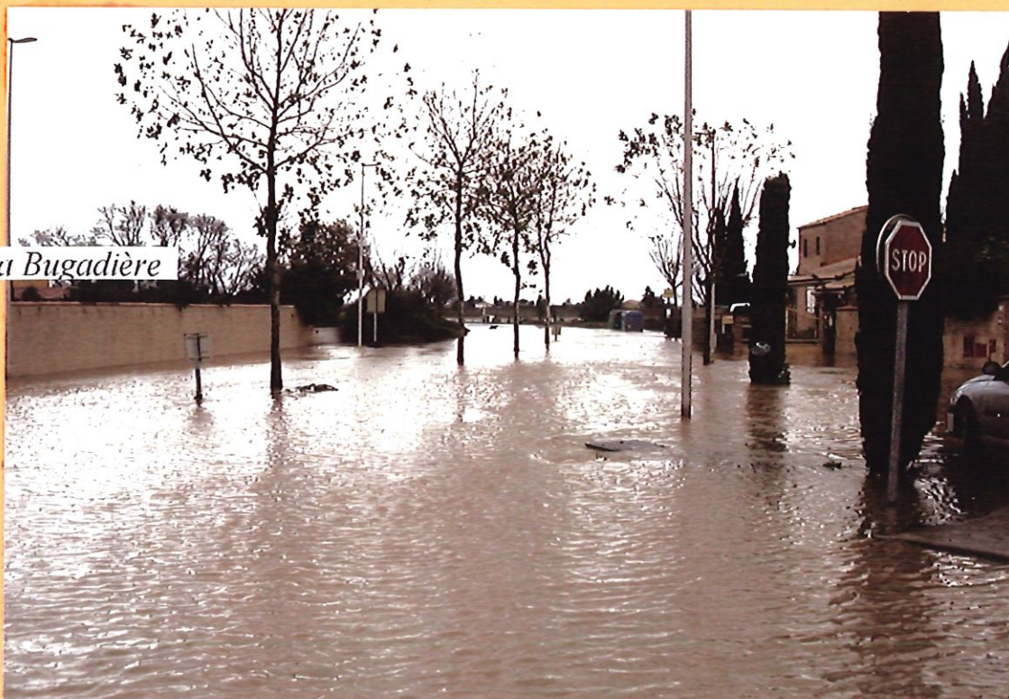
LUNEL-VIEL : Dardailhon Est . Crue du 3 décembre 2003 Rue Antoine Roux - CD 110 - l'eau remonte jusqu'à la rue de la Saladelle, lotissement La Bugadière . Le reprofilage de la rue et la mise en dévers en 1995, font obstacle à l'écoulement des eaux de crue.
